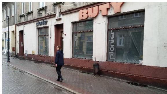
Fot.2. Zamknięte sklepy przy ul. Kościuszki
