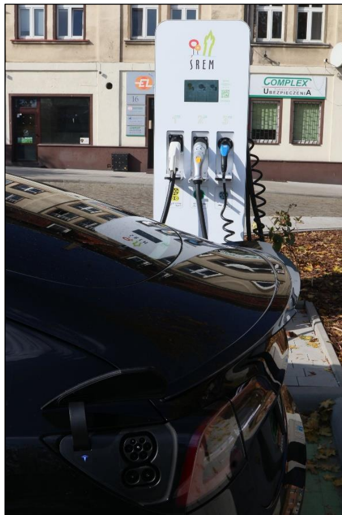
Rysunek 19 Stacja ładowania pojazdów na terenie węzła przesiadkowego przy ul. Stary Rynek w Śremie
