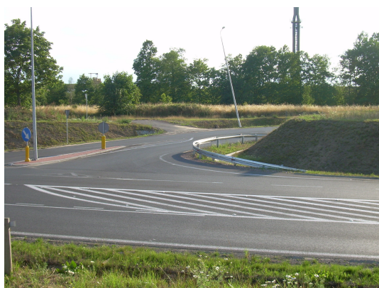
Fot. 4 – Widok na skrzyżowanie obwodnicy.
