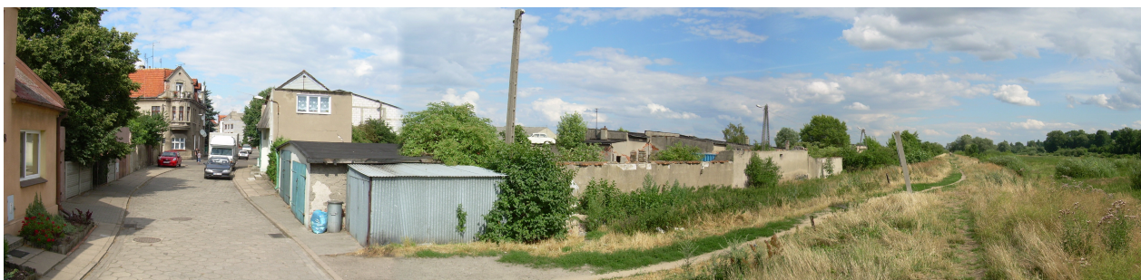
Fot. 1. Widok od strony walu przeciwpowodziowego, narożnik ul. Mała Łazienkowa.
