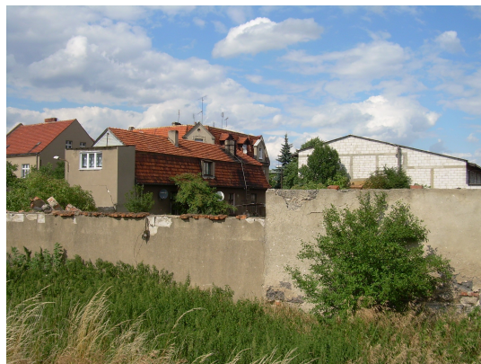
Fot. 5. Widok od strony wału przeciwpowodziowego, budynek mieszkalny przy ul. Mała Łazienkowa
