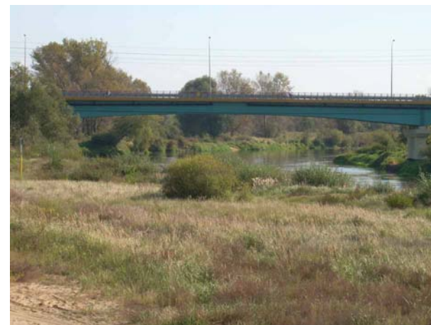
KORYTO RZEKI WARTY WIDOK NA DROGĘ WOJEWÓDZKĄ
