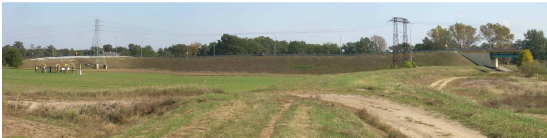
WIDOK W STRONĘ GRANICY WSCHODNIEJ OPRACOWANIA MIEJSCOWEGO PLANU - NASYP DROGI WOJEWÓDZKIEJ
