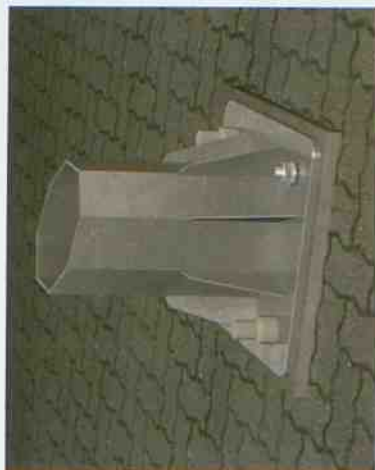
Przykład klinowania dla masztów powyżej 18 m
