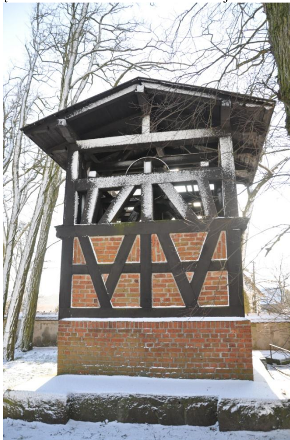
Drewniana dzwonnica konstrukcji szkieletowej z roku 1878 (źródło: internet) Pozostałymi obiektami z gminnej ewidencji zabytków są:
