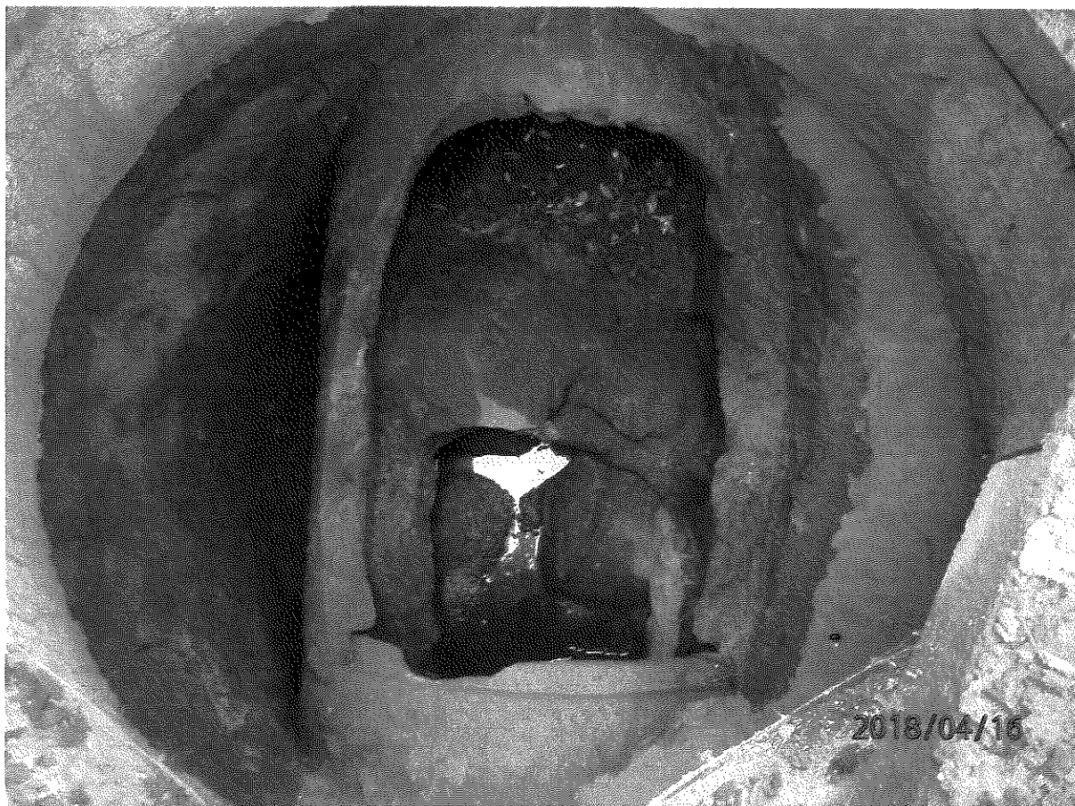
Rys.2.3 Widok trzonu studni wraz z stopniami
