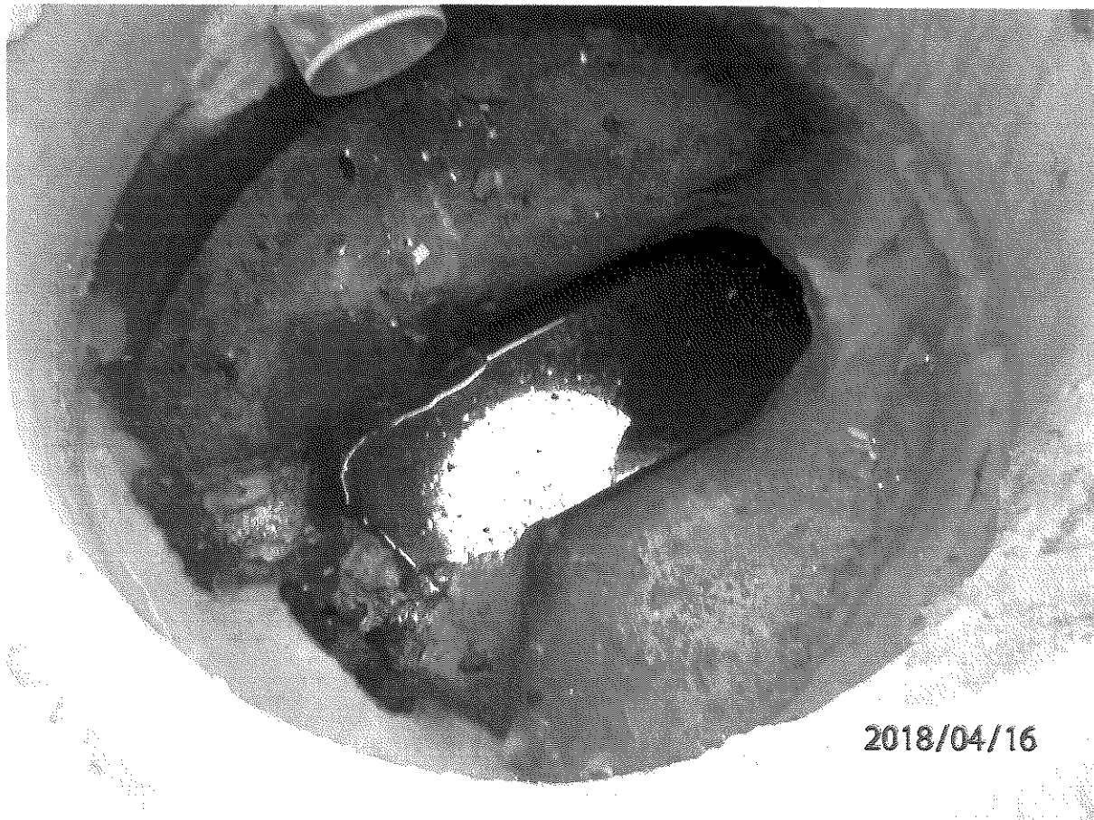
Rys.6.3 Kineta studni istniejącej w ul. Małej Łazienkowej z włączeniem nowego odcinka fi 315 i przykanalika na skrzyżowaniu z ul. Piaskową
