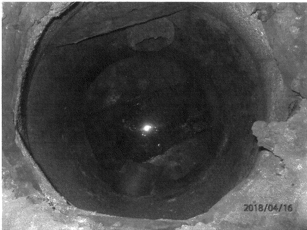
Rys.4.2 Widok kinety przelotowej z wpustami
